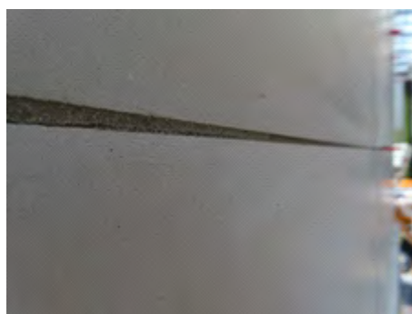
Oberflächenqualität MSPG, abzogener Mörtel (frisch)
